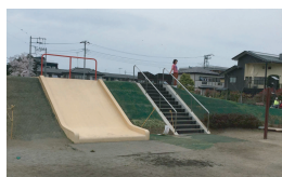
大けやき公園の修復工事（階段設置）
