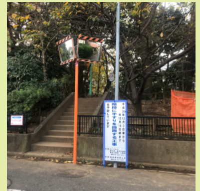
駒場緑地の階段の手すり設置工事
