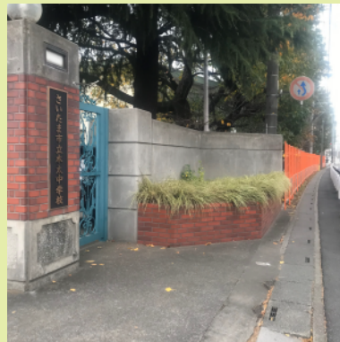
本太中学校のブロック塀撤去工事
