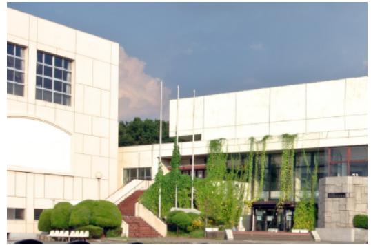
空調設備の導入が実現した浦和駒場体育館
