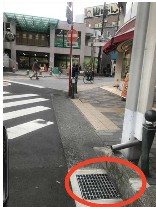
ロータリー交差点に設置された排水枡
